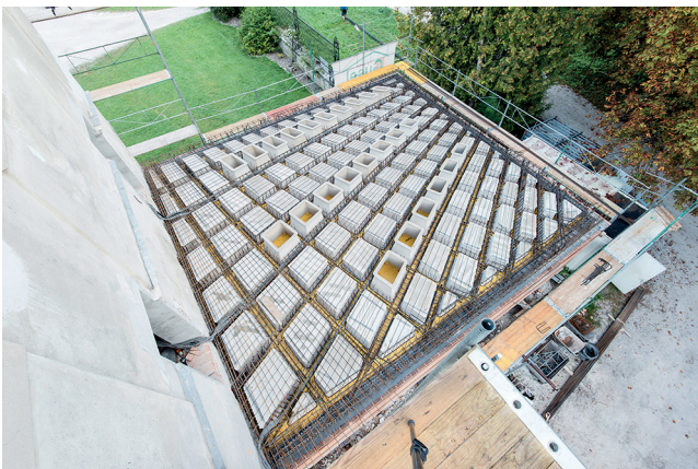
Abbildung 6: Eingebraachte Aussparungskörper mit konventionell verlegter Bewehrung; Atelier Kupelwieser (Lunz am See); © ITE, TU Graz
