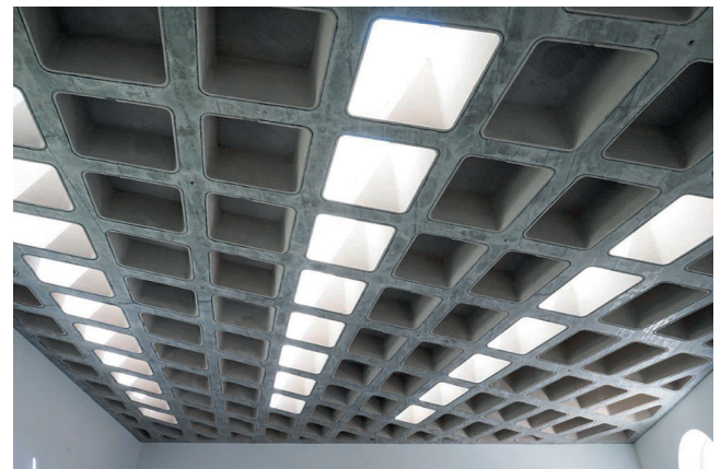
Abbildung 7: Untersicht nach Betonage; Atelier Kupelwieser (Lunz am See); © ITE, TU Graz
