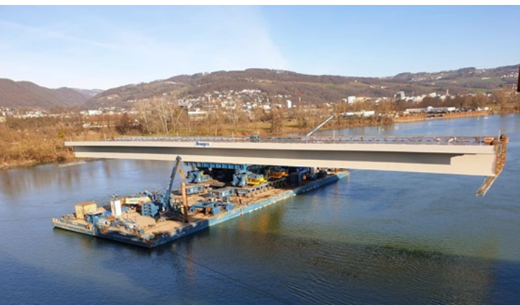
Einschwimmen Brückentragwerk A7, 2019
