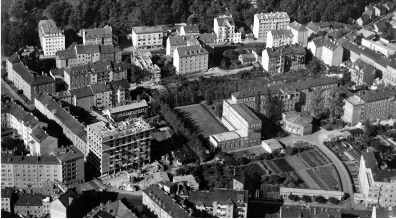
Baustelle Haus der Technik, 1960
