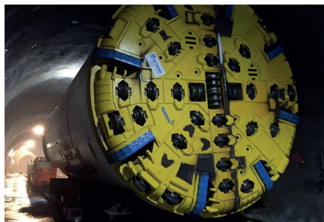
Abbildung 1: Tunnelvortriebsmaschine in der Startkaverne (© Tiroler Wasserkraft AG)
