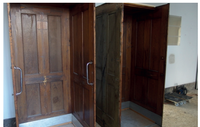
Abbildung 1: MedUni Campus Mariannengasse – Paternosterkabinen: Unter den besonderen Re-Use-Stücken des MedUni Campus Mariannengasse waren auch 100-jährige Paternosterkabinen (© BauKarussell)
