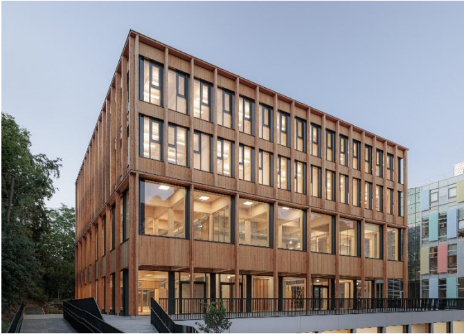
Abbildung 1: Außenfassade des BOKU Gebäudes © Florian Voggeneder
