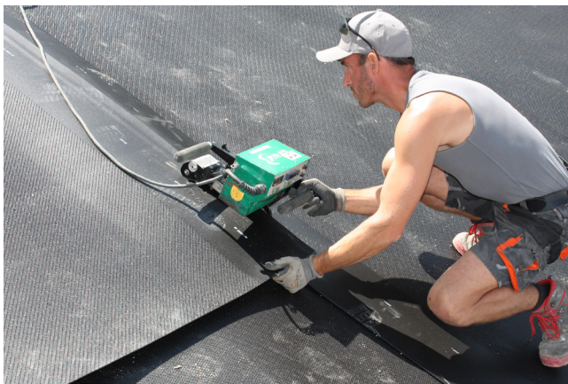
Abb. 2: Verschweißung eines Kunststoffliners (Quelle: AGRU Kunststofftechnik GmbH und IAT GmbH)
