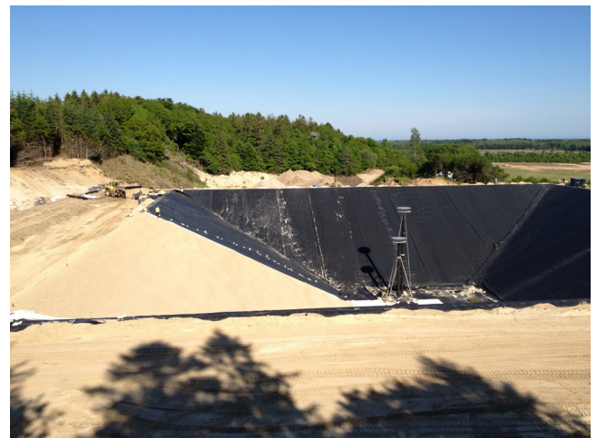
Abb. 1. Erdbeckenspeicher mit Kunststoffabdichtung (Quelle: PlanEnergi, Dronninglund Fjernvarme (DK))
