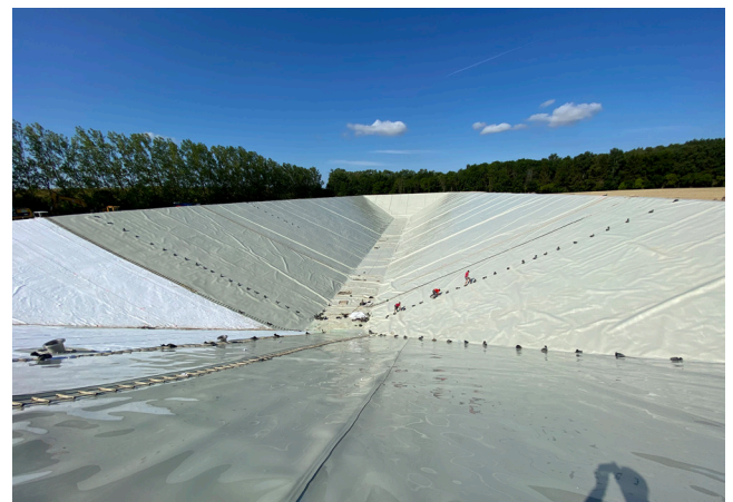
Abb. 5. Verlegung des neuartigen PP-HTR-Kunststoffliners in Høje Taastrup (DK; Quelle: AGRU Kunststofftechnik GmbH und G quadrat Geokunststoffgesellschaft mbH)
