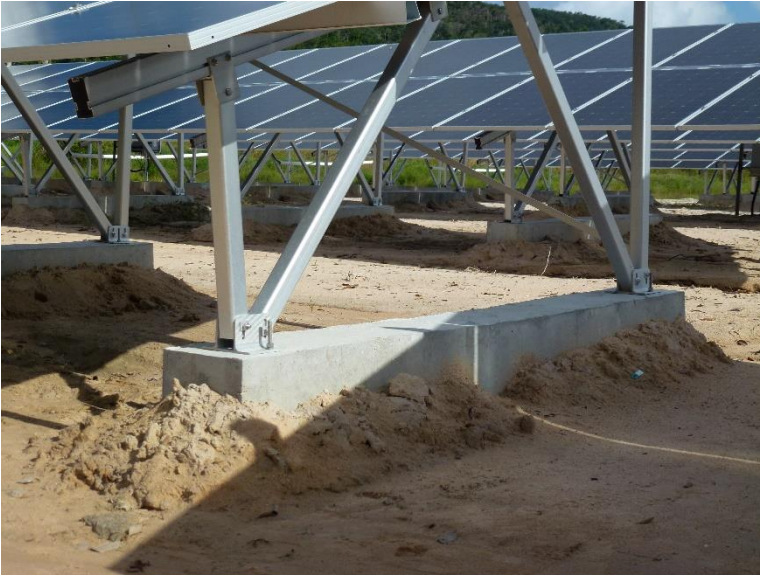
Abbildung 3 Wegen des sehr sandhaltigen Bodens und des starken Niederschlags in der Regenzeit wurden Betonfundamente als Befestigung gewählt. © 2020 Ortner Energy Group
