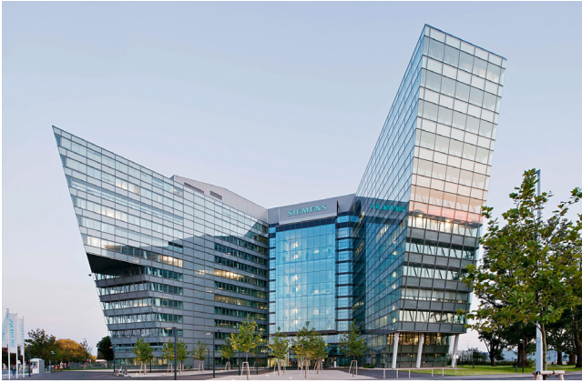
Die Siemens City in Wien: Hier wird momentan ein einzigartiges Microgrid-Projekt errichtet.
