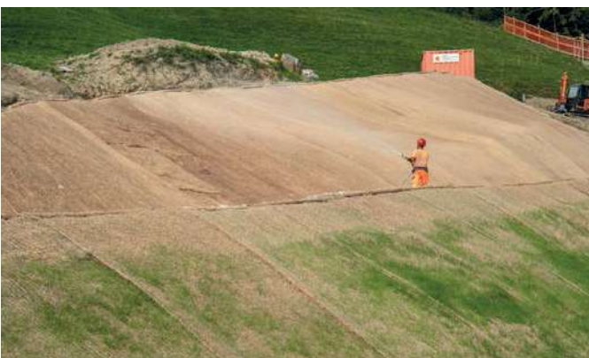
Verlegtes Holzwollevlies an einer Böschung.
