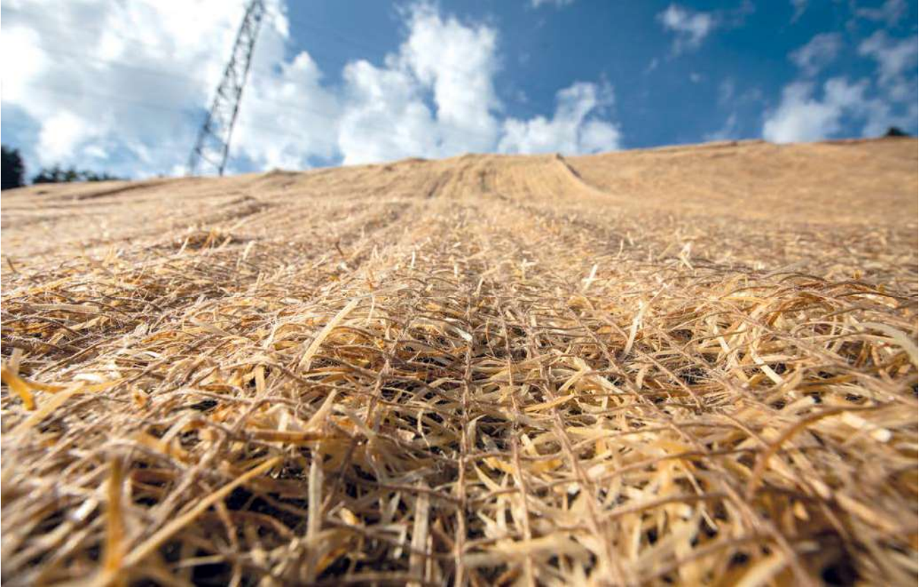
Verlegtes Holzwollevlies an einer Böschung.
