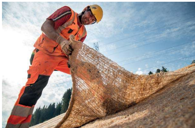
Verlegen am Hang.
