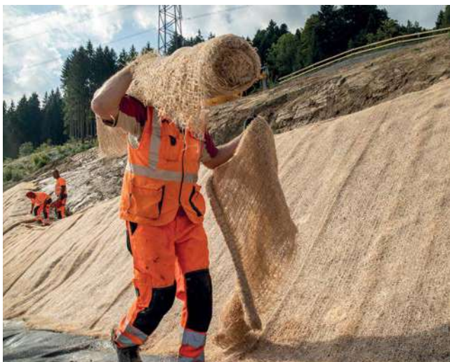
Verlegen des Holzwollevlieses ab der Rolle.
