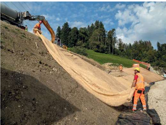
Anbringung des Erosionsschutzes aus Holzwolle.
