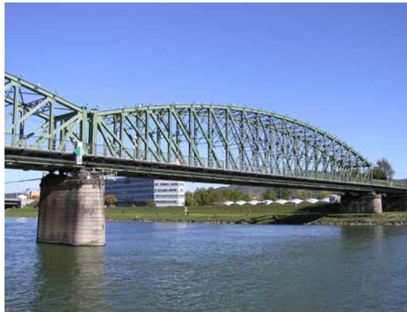
Historische Linzer Eisenbahnbrücke – kontrovers diskutiertes Bauwerk (© Stadt Linz)
