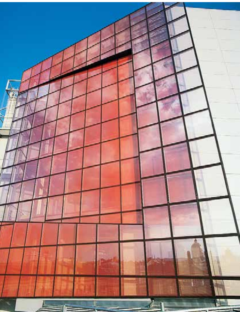
Chemiehochhaus der TU Wien am Getreidemarkt: Positives Beispiel für eine gelungene Aktualisierung eines Bestandsgebäudes (© TU Wien)
