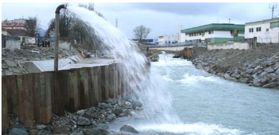
Hochwasserschutz-Projekt Sill-/Inn-Mündung (Foto: PR-Team Baufakultät)
