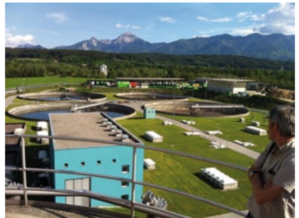
Kläranlage Villach vom Faulturm aus gesehen, Berg in Bildmitte: Mittagkogel (Bild: Verein der Österreichischen Sicherheitsingenieure/Paul)
