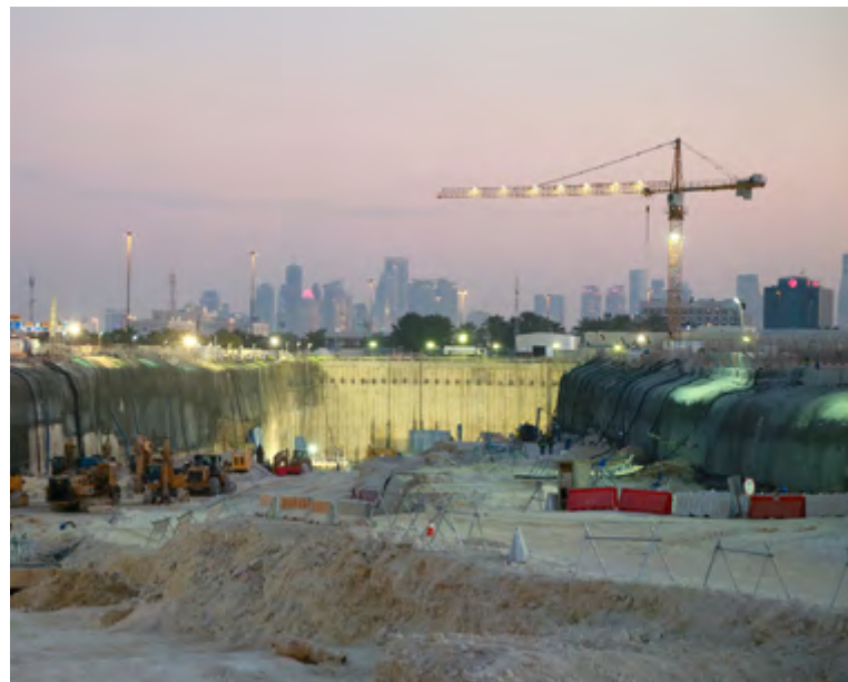
Besonders tiefe und große Baugruben, wie hier bei einer Baustelle im katarischen Doha zu sehen, bringen einige geotechnische Herausforderungen mit sich (Foto: Keller Holding GmbH)
