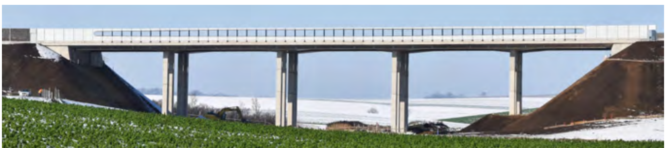
Satzengrabenbrücke – Österreichs längste integrale Brücke (Foto: TU Wien)
